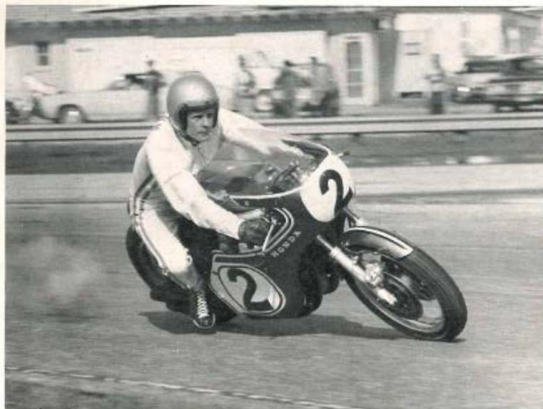
Mit einem Rennwagen-ähnlichen Geräusch (verursacht durch die drei Zylinder, deren Auspuffrohre in ein gemeinsames Megaphon zusammengeführt waren!) schoß die Triumph von Gene Romero um den Kurs und erzielte eine Durchschnittsgeschwindigkeit von 157,34 mph, bis 165 mph (= ca. 265 km/h!) wurden auf dem schnellsten Stück gestoppt.
